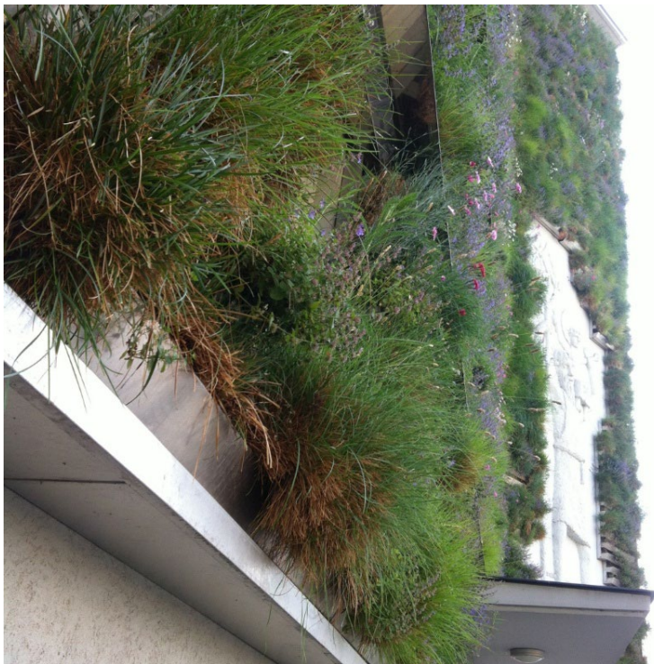
Fassadengebundene Begrünung | Gräser | © GREEN4CITIES
