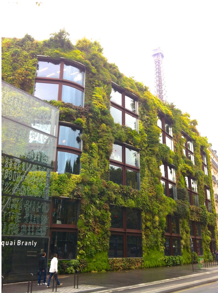
Fassadengebundene Begrünung | vollflächiger Vegetationsträger | Lage der Pflanze 90° | Gesamtsystem | © GREEN4CITIES
