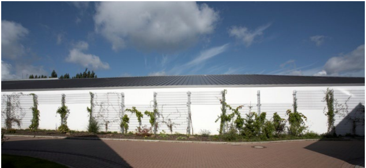
Bodengebundene Begrünung mit starrer, flächiger Kletterhilfe | © LEGI A.2 Mit Kletterhilfe / A.2.1 Starr / A.2.1b Linear
