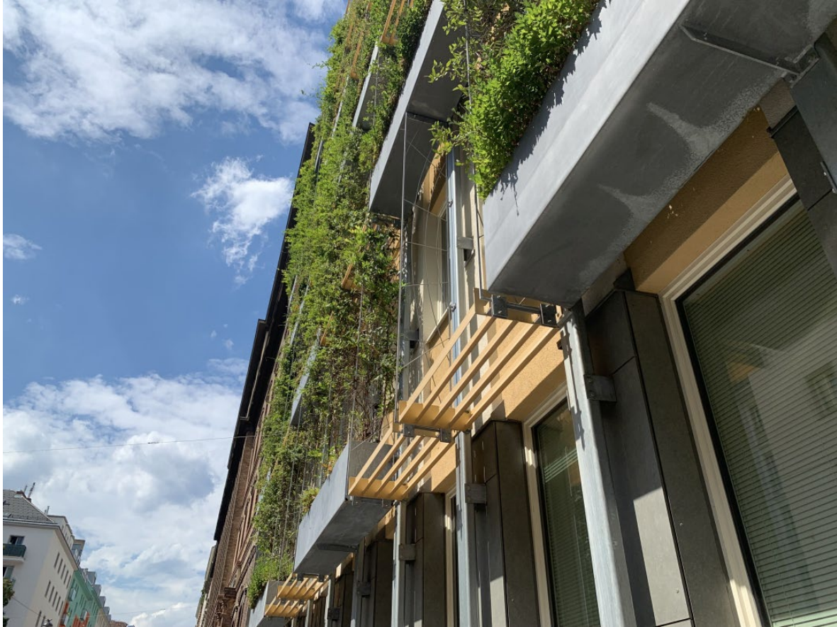
Fassadengebundene Begrünung | teilflächiger Vegetationsträger | punktuell | © GREEN4CITIES
