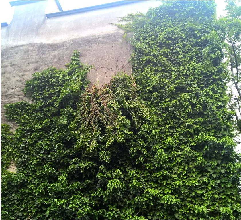
Wind,- Eigenlast und fehlende Haftung führte zum Ablösen des Efeus | © Stadt Wien – Umweltschutz
