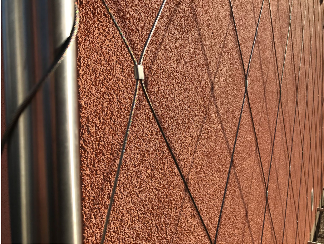
Kletterhilfe / Seilnetz / flexibel / flächig / © GREEN4CITIES
