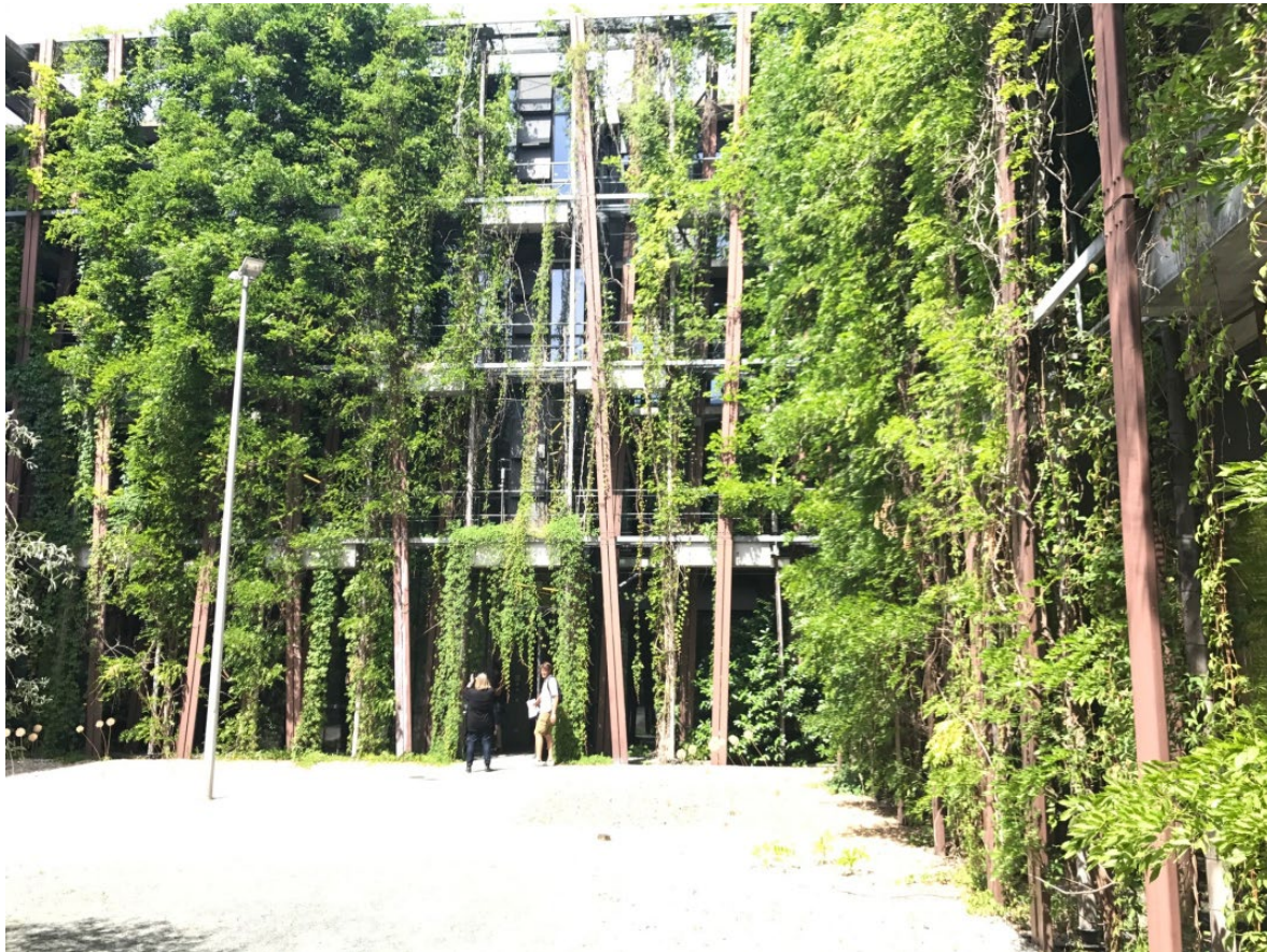
Fassadengebundene Begrünung / teilflächiger Vegetationsträger / punktuell / © GREEN4CITIES
