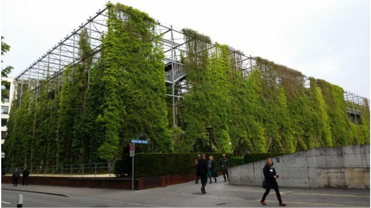
Bodengebundene Begrünung mit starrer, flächiger Kletterhilfe | MFO Park | Zürich | © VfB
