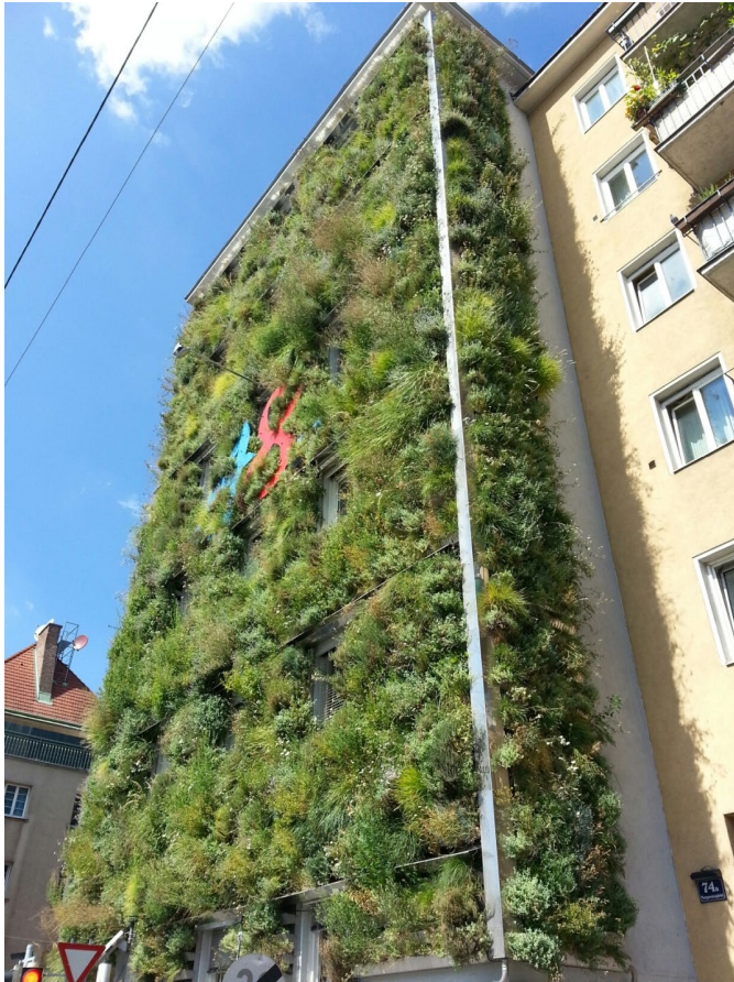
Fassadengebundenes System / südseitige Exposition / MA-48-Fassade / Wien / © VfB
