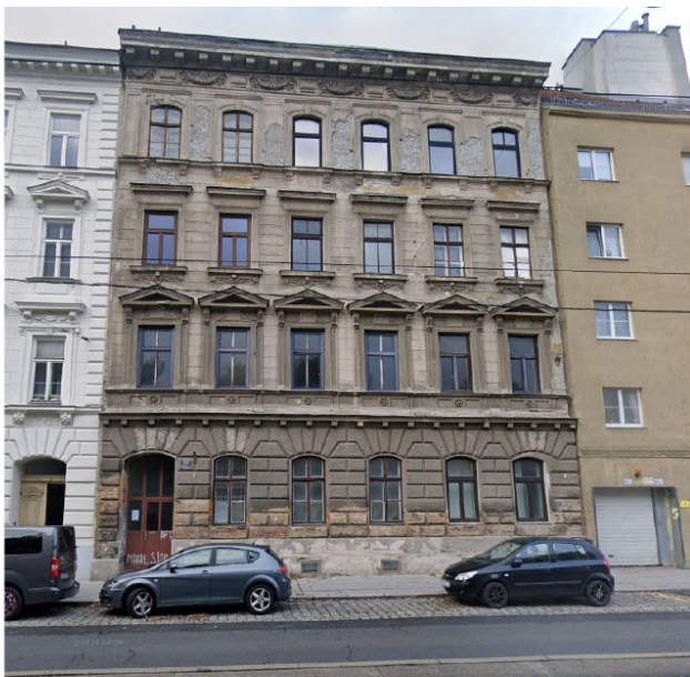
Straßenfassade, Bildquelle: google maps
