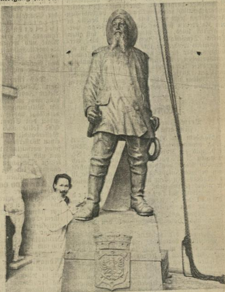
Das Nagelungsstandbild der Stadt Wilhelmshaven wurde vor kurzem enthüllt.
