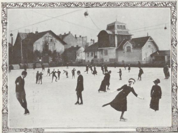
Teilansicht der Kunsteisbahn mit dem neuen Maschinenhause.
