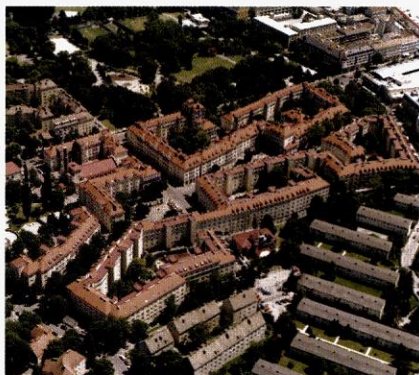
△ Gebäude der Zwischenkriegszeit, Zeilenbebauung
